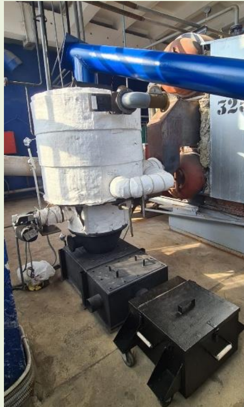
Реактор и система выгрузки золы
