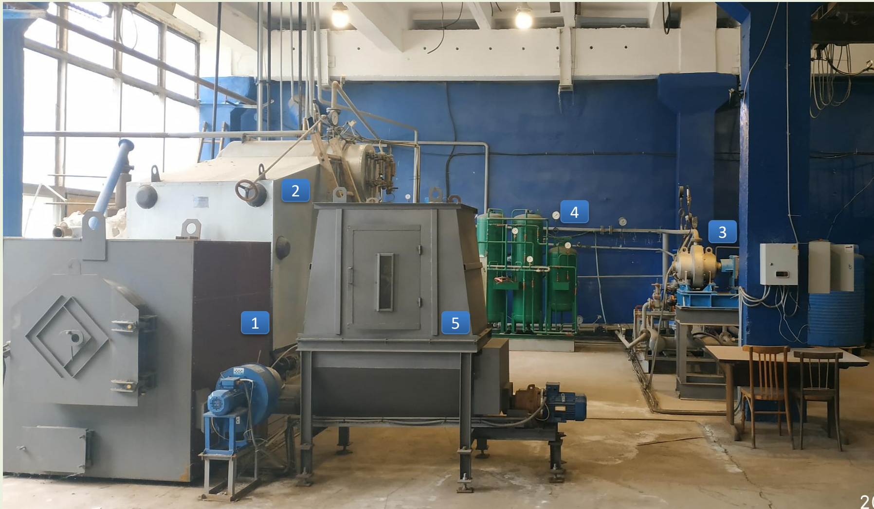
1 – модуль энергетической утилизации, 2 – парогенераторный модуль, 3 – турбогенераторный модуль, 4 – модуль водоподготовки, 5 - бункер подачи исходного топлива
