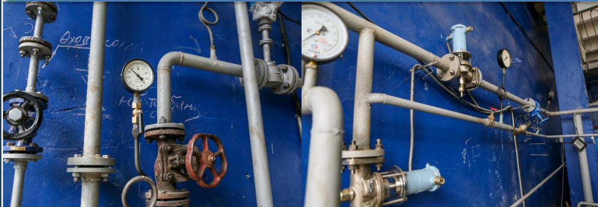
Манометры, термодатчики, регулирующие, отсечные, запорные клапаны, паро- и трубопроводы
