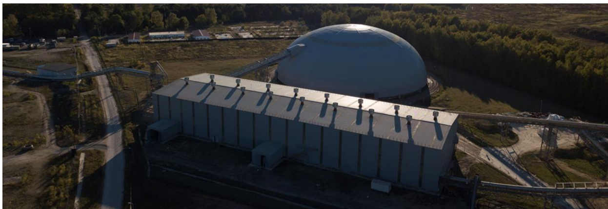
Рисунок 15 – Цех подготовки альтернативного топлива на цементном заводе компании ООО «Холсим (Рус) в Ферзиково
