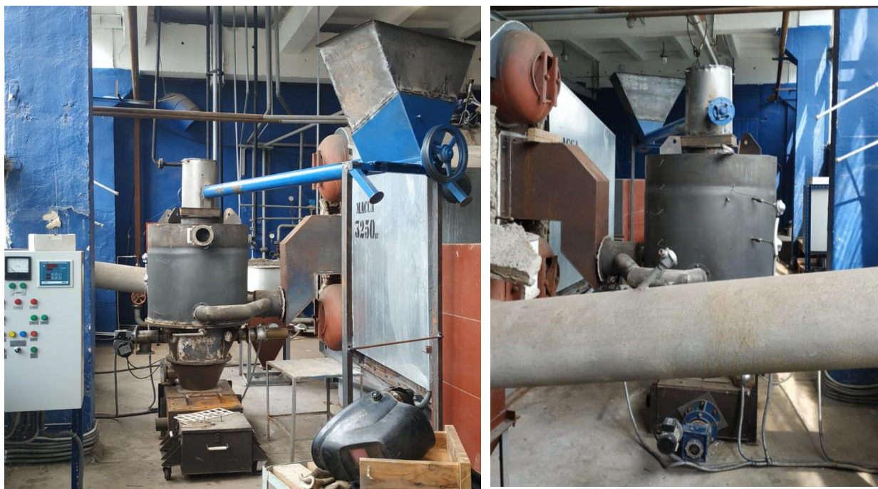
Рисунок 3 – ЭТК в процессе монтажных и пуско-наладочных работ
