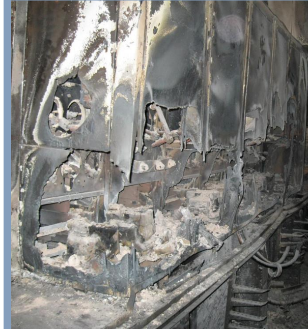
Разрушения КРУ при дуговом КЗ
