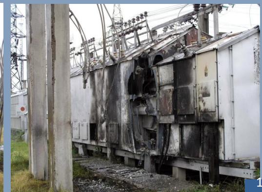
Разрушения КРУ при дуговом КЗ
