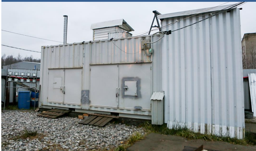
Контейнерное исполнение установки по переработке ТКО методом пиролиза на площадке РНЦ «Прикладная химия»
