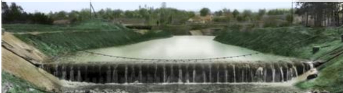
Мембранно-вантовая конструкция на р. Рать, Курская область
