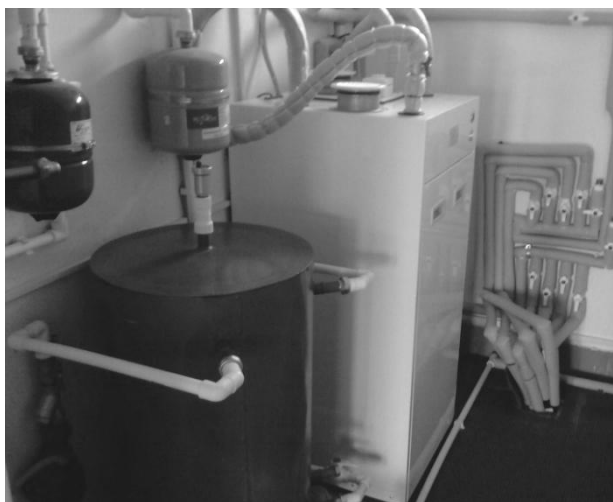
Рис.4 Тепловой пункт энергообеспечения «умного дома»
