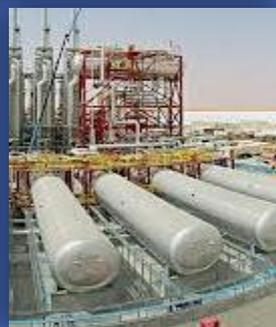
Shams 1 - крупнейший в мире завод концентрированной солнечной энергии. Завод, мощностью 100 МВт, расположенный в 120 км к юго-западу от столицы, использует технологию параболических желобов для преобразования энергии солнца в электричество.
