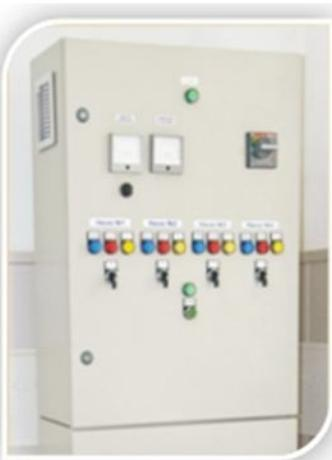
Система предназначена для автоматической поддержания заданного технологического параметра (давление, уровень, расход) путем плавного изменения производительности одного насосного агрегата и автоматического изменения числа работающих насосных агрегатов.
